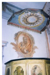
Chaire à prêcher après restauration
